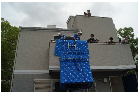
2 階のベランダから家財を搬入する「窓吊技術」
